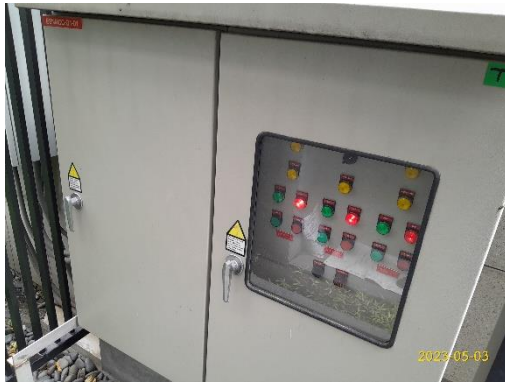
แผงควบคุมเครื่องสูบน้ำบ่อน้ำ
