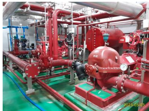
เครื่องสูบน้ำดับเพลิงชุด High Zone
