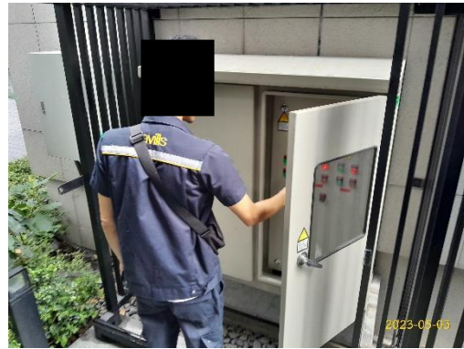
แผงควบคุมเครื่องสูบน้ำบ่อน้ำ
